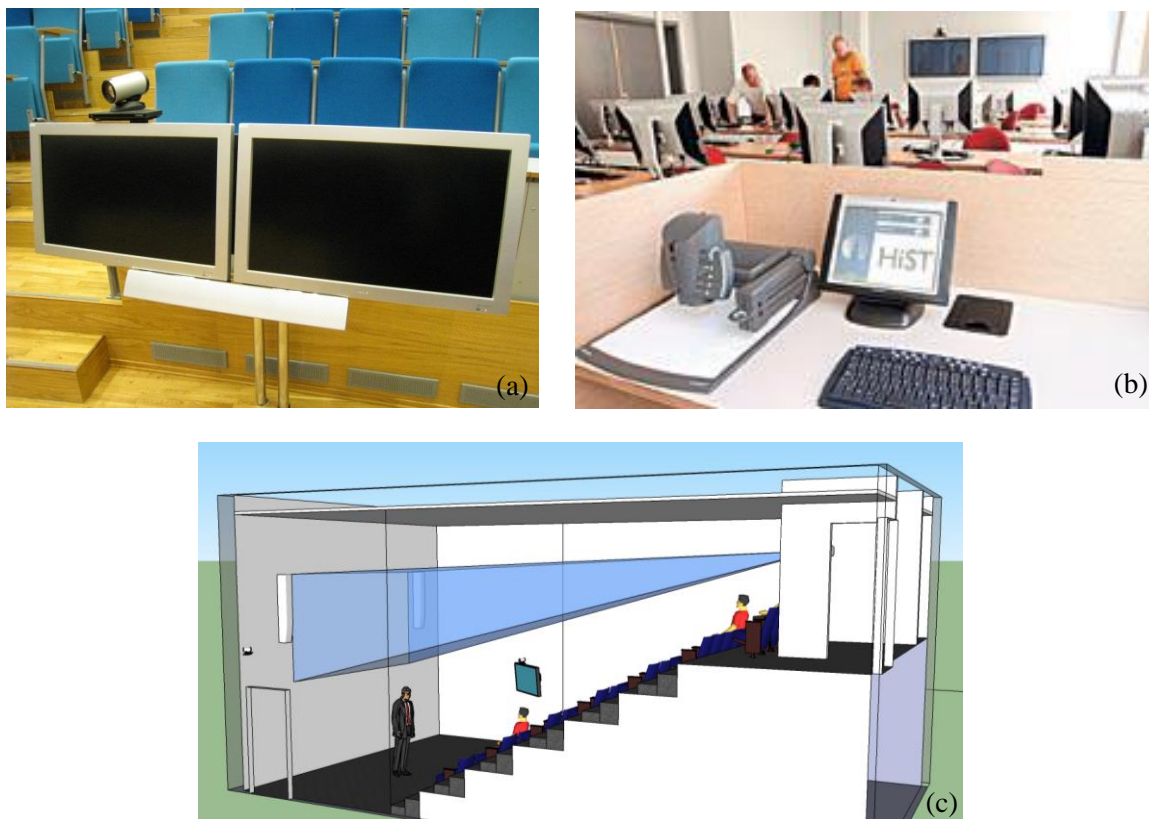
Figur 22. Eksempel på medsynsløsninger. Skjermer foran første rad (a), på bakvegg (b) og på sidevegg (c).
